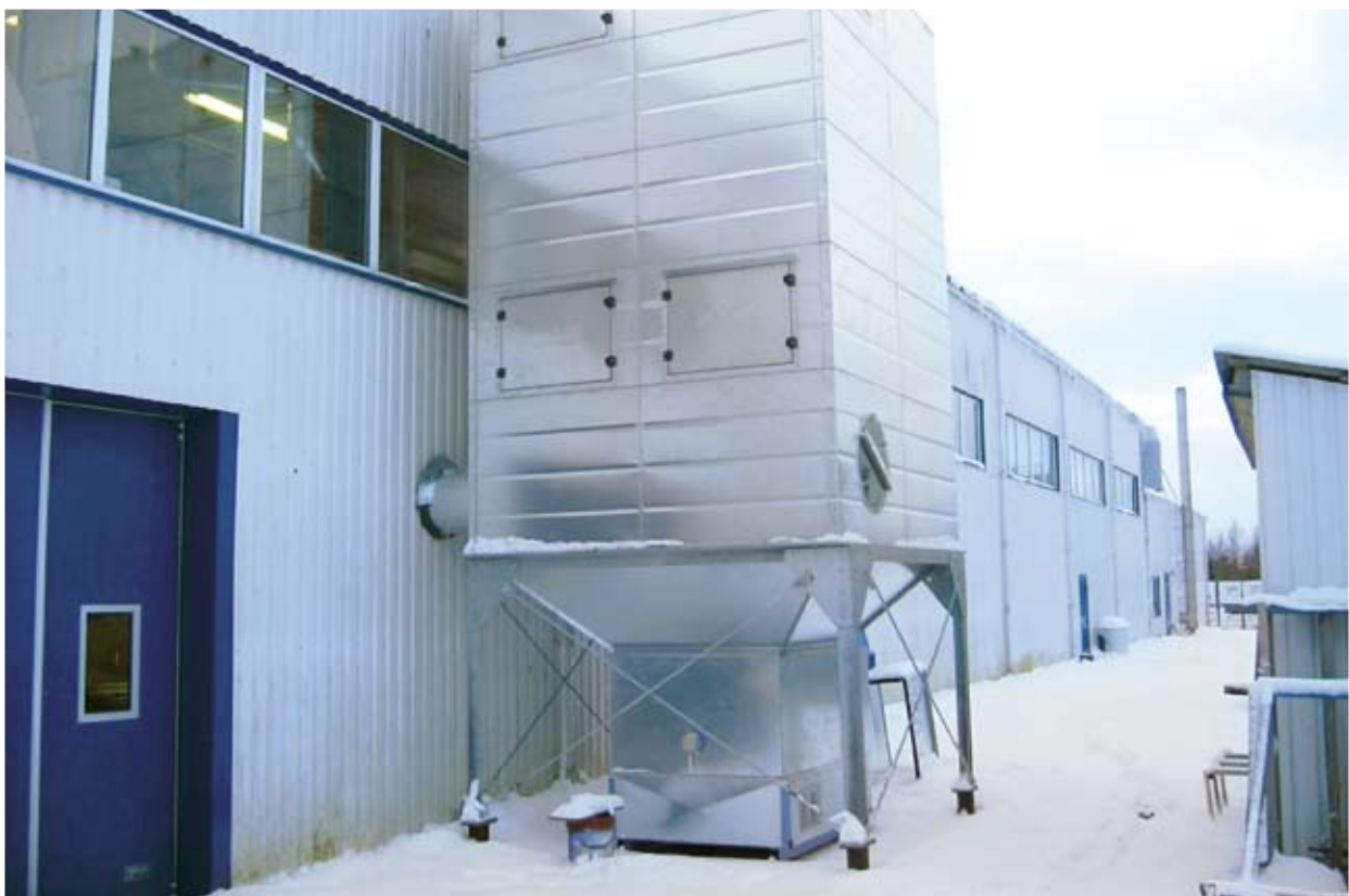
BrikStar C mit Wetterschutzverkleidung unter einer Höcker Polytechnik Filteranlage
